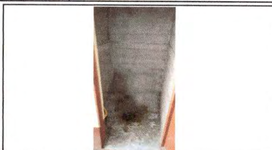
FOTO 2: Sustitución de piso de torta de concreto por piso cerámico, Sustitución inodoro y Sustitución de Azulejo, en modulo de baños
