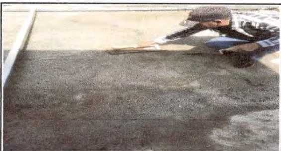
FOTO 17: Reparación de planchas de concreto en modulo de patio
