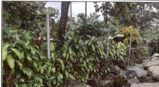
FOTO 14: Reparación de tubo hg y malla galvanizada en modulo de patio
