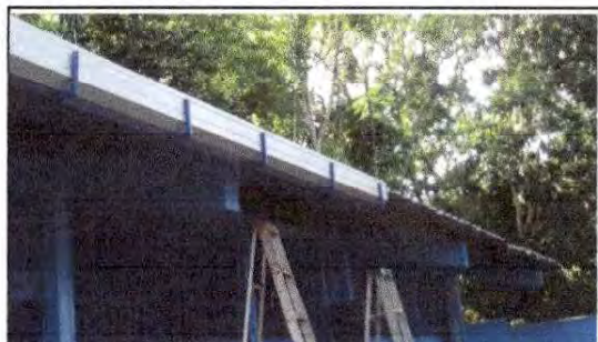
FOTO 9: Sustitución de canal de metal y Reparación de bajada de agua pluvial, tubo PVC 3" en modulo patio
