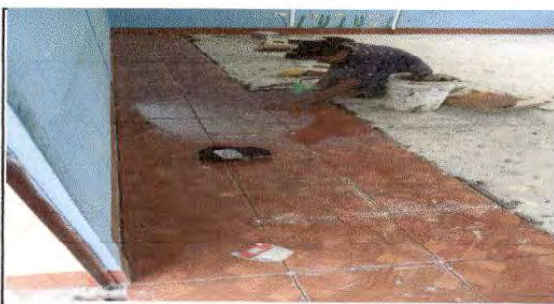
FOTO 18: Sustitución de piso de torta de concreto por piso ceramico (AULA 1, 2, 3 y 4)
