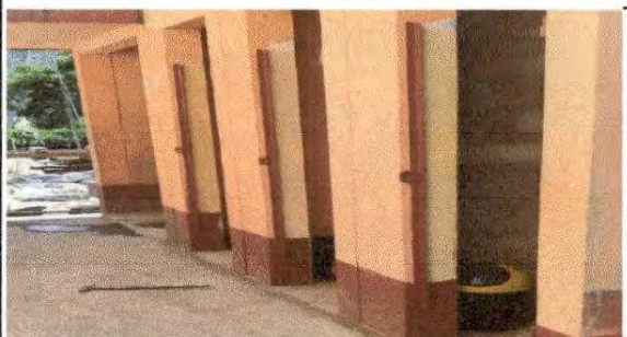
FOTO 3: Mantenimiento a estructura (lijado, cambio de tubo , cepillado, sujeciones, aplicación de pintura) a puertas servicios sanitarios
