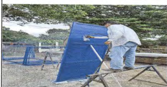
FOTO 13 : Fabricación e instalación de puertas de metal en módulo de cocina
