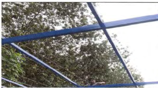
FOTO 12: Sustitución de lámina, por lámina troquelada aluzinc calibre 26 en modulo de cocina
