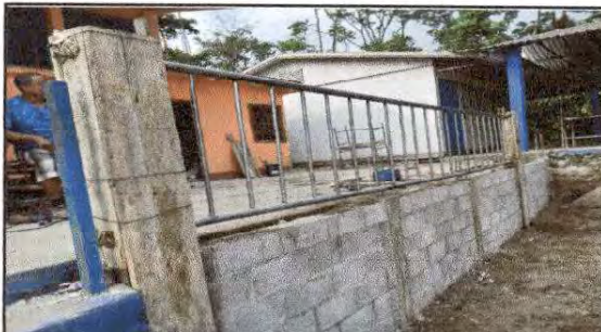
FOTO 16: Sustitución de baranda de madera por baranda de metal. Modulo de patio
