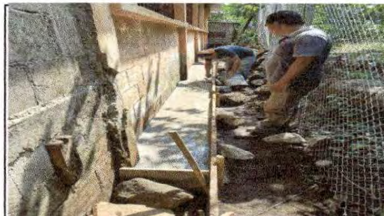
FOTO 10: reparación de cuneta de concreto. Modulo patio
